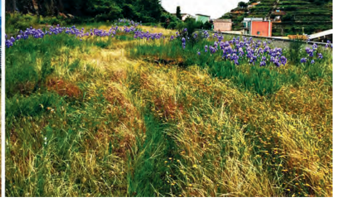
4. Dağdan getirilen toprak ile oluşturulan yeşil çatı sonbahar ve ilkbahar görüntüsü, sulama yapılmıyor, sene 1 kez bakım yapılıyor.
