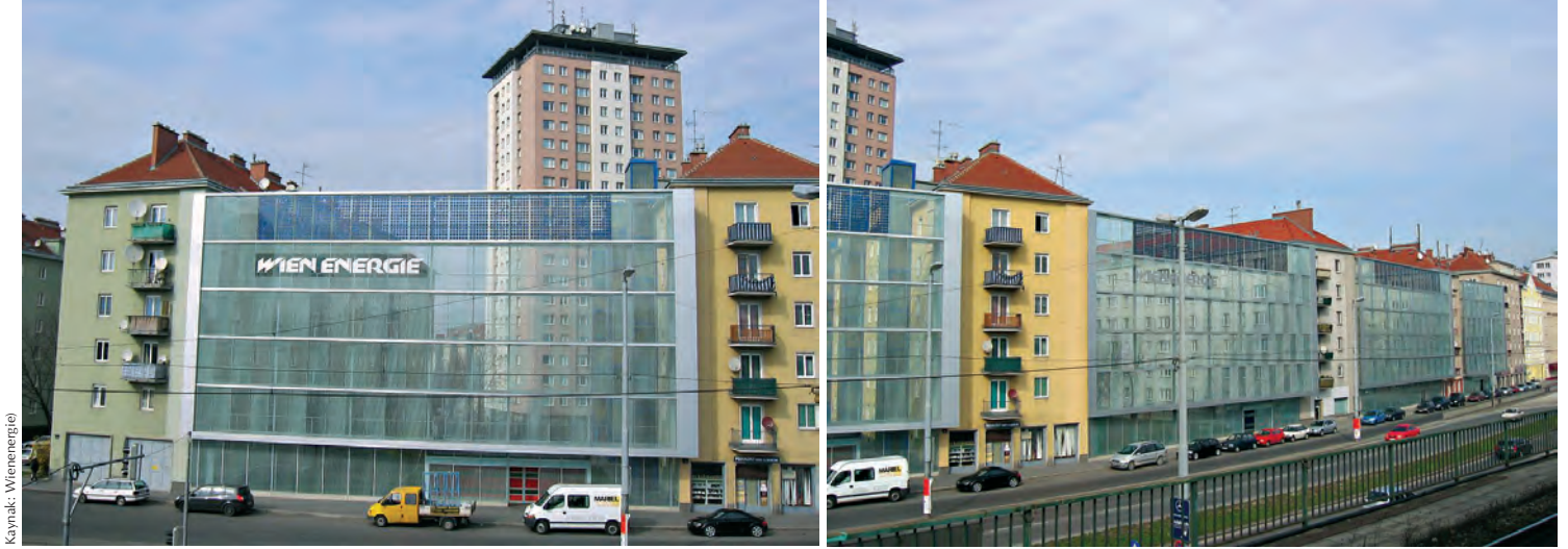
6. Theodor-Körner-Hof'da "gürültü koruma duvarı". Viyana Enerji Kurumunun üstlendiği projede aynı zamanda fotovoltaik panellerle elektrik elde edilmesi de öngörülmüş.
