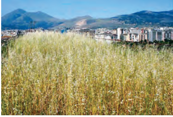
4. Dağdan getirilen toprak ile oluşturulan yeşil çatı sonbahar ve ilkbahar görüntüsü, sulama yapılmıyor, sene 1 kez bakım yapılıyor.
